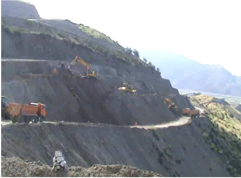
Travaux de déblai
