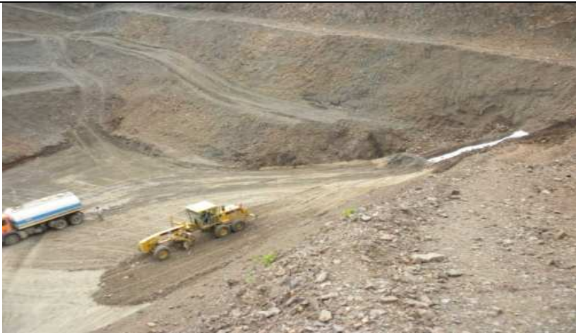
Travaux de remblai de grande hauteur
