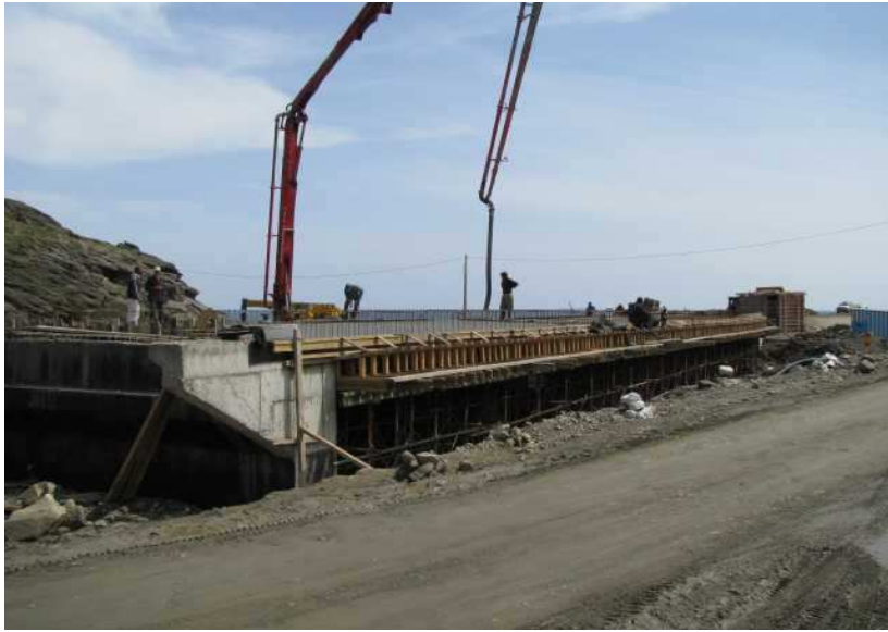
Bétonnage de la dalle du pont sur oued Targha
