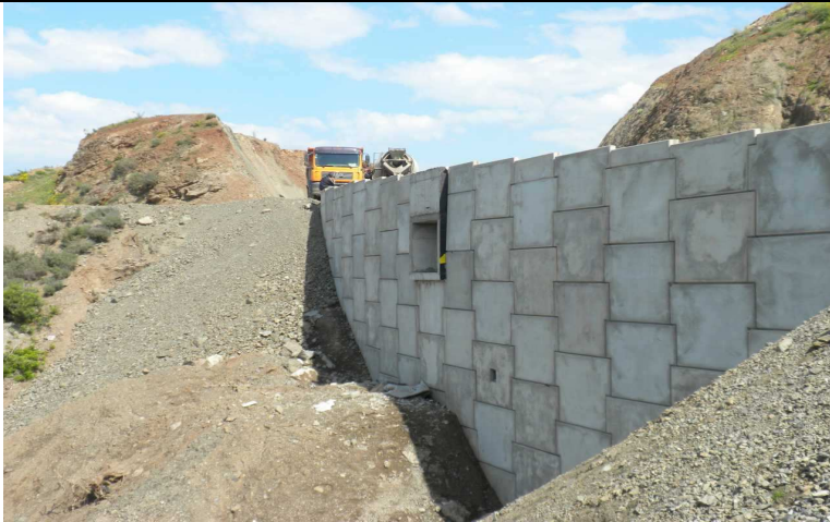
Mur de confortement en terre armée
