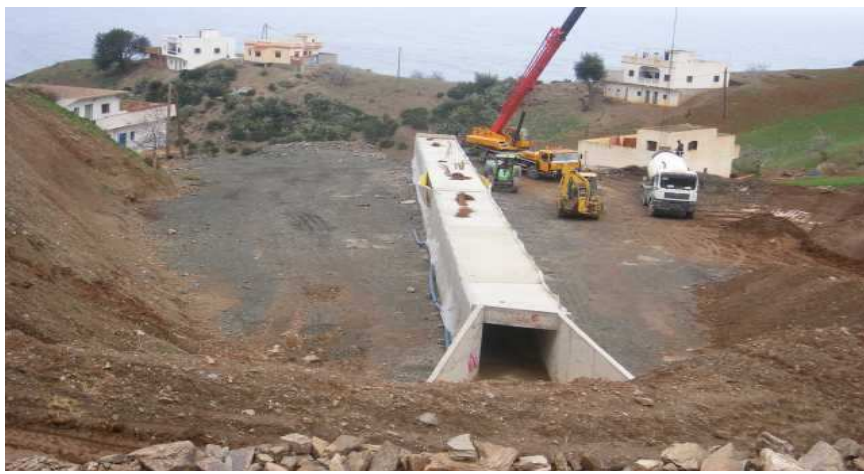
Construction d'un ouvrage hydraulique de type dalot
