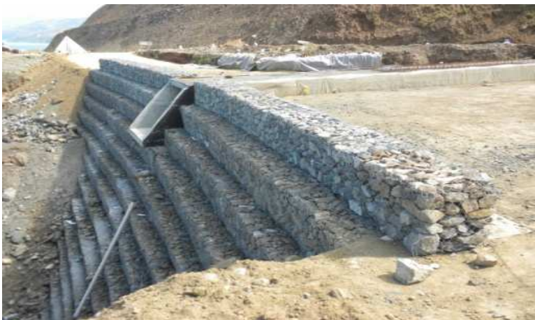
Ouvrage de confortement en remblai renforcé
