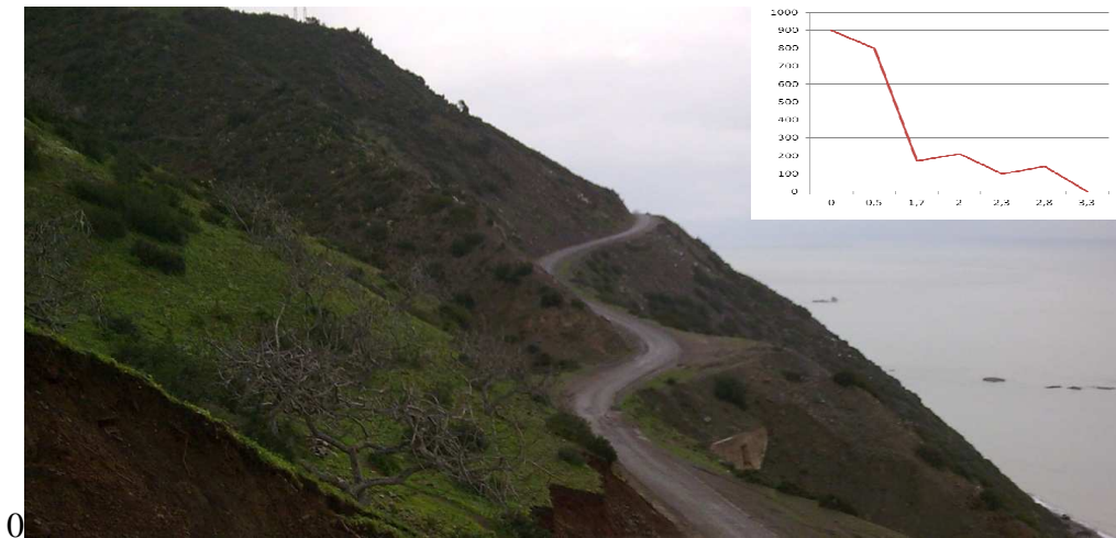
fig 3 : photo et profil en travers type du versant au niveau d'Amter
